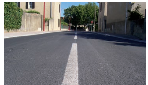
Avenue Bombanel rénovée, Jonquières
