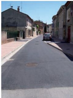
Rue des Remparts rénovée, Sorgues
