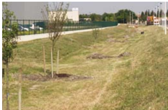
La plantation d'arbres dans les noues communes renforce la protection contre les inondations
